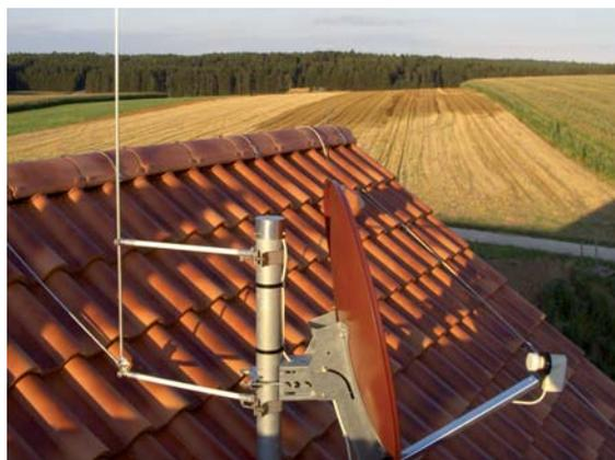
Fig. 5.1.2.5: Antena con punta captadora.
