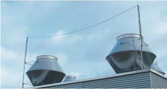
Fig. 5.2.4.2.3a: Ventiladores con puntas captadoras y tendido de cable.
