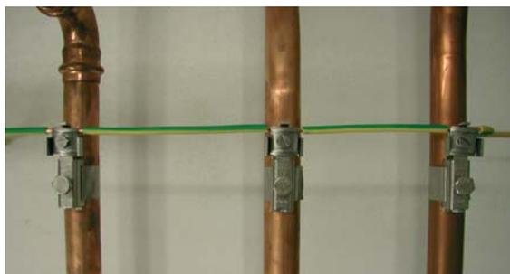
Fig. 6.1.6 Compensación de potencial con cableado de paso.
