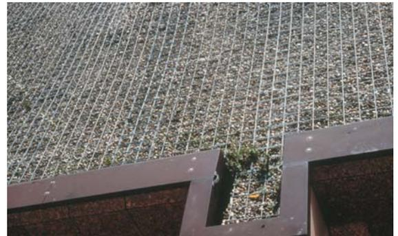
Fig. 7.3.7a: Rejillas de acero galvanizadas.
