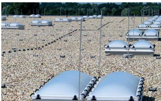
Fig. 5.1.1.19: Tejado plano con puntas captadoras y soportes de conductor: Protección de lucernarios.
