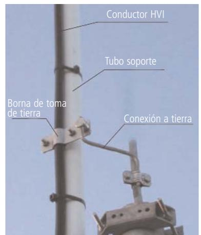
Fig. 5.2.4.2.2b: Conexión al soporte de la antena para control de potencial.
