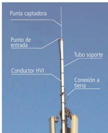
Fig. 5.2.4.2.2a: Tubo aislante en la zona de la antena.
