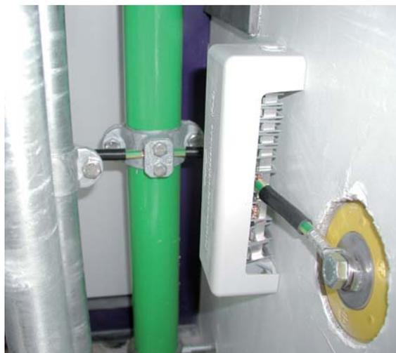
Fig. 7.5.1.1: Conexión de barra equipotencial a un punto fijo de toma de tierra
