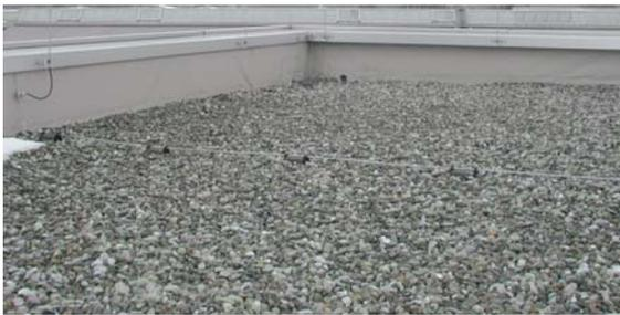
Fig. 5.1.3.2: Instalación captadora sobre tejado plano.
