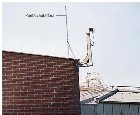
Fig. 9.7.2: Cámara de vigilancia en la zona de protección de una punta captadora.
