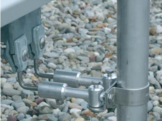
Fig. 5.1.8.13: Detalle de un DEHNiso-Combi.
