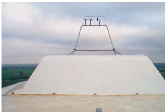
Fig. 5.1.10.2: Protección contra rayos de anemómetros situados en un aerogenerador.
