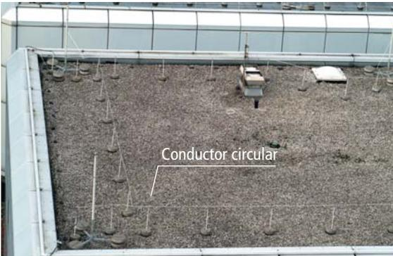
Fig. 5.2.4.2.3b: Punta captadora, conductor circular elevado con conexión a sistema derivador aislado.
