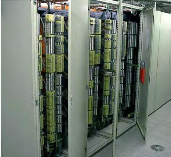
Fig. 9.4.7: Descargadores de sobretensiones DCO ME 24 instalados en cuadro para la completa protección del sistema de medida y control.
