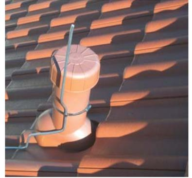
Fig. 5.1.2.3: Elementos captadores adicionales para tuberías de ventilación.
