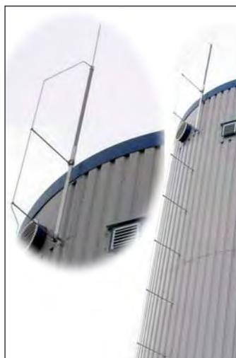
Fig. 9.3.7: Protección del depósito fermentador con planchas de metal con dispositivo captador separado. (Fuente: Büro für Technik, Hösbach).
