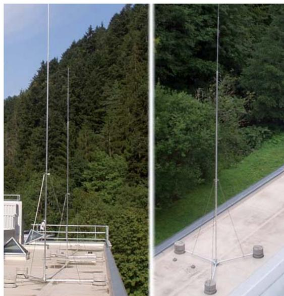
Fig. 5.1.11.1: Protección contra descargas directas de rayo mediante puntas captadoras autoportadas.
