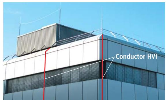
Fig. 5.2.4.2.5: Sistema captador con cable tendido y sistema derivador aislado.
