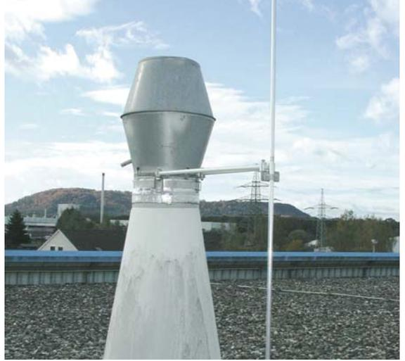
Fig. 5.1.8.3: Punta captadora con soporte distanciador.
