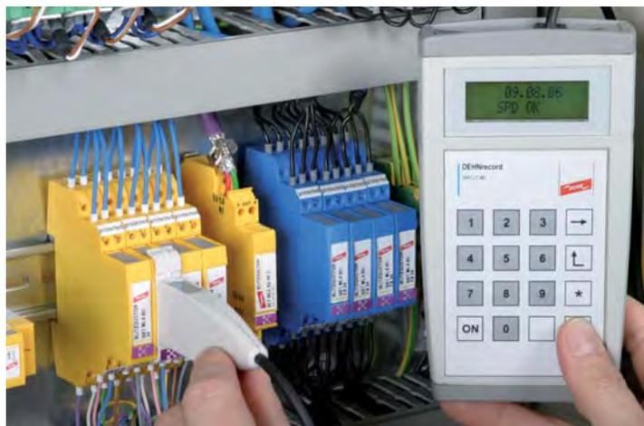
Fig. 9.3.12: Módulos de descargador combinado con LifeCheck.
