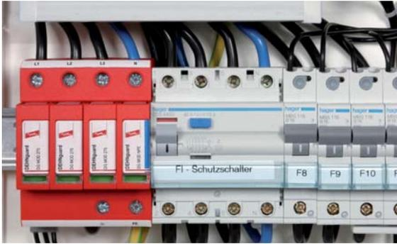
Fig. 7.7.2.3: Descargador multipolar de sobretensiones DEHNGuard M TT.
