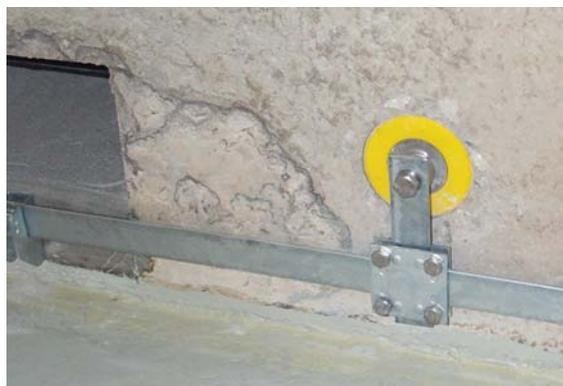
Fig. 7.7.1.1: Anillo de compensación de potencial y punto fijo de toma de tierra para la conexión de instalaciones metálicas.
