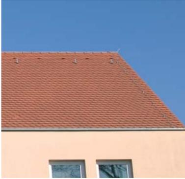
Fig. 5.1.2.1: Instalación captadora sobre tejado a dos aguas.
