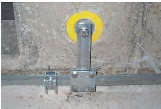
Fig. 7.4.3: Unión del anillo circular de compensación de potencial con la red de compensación de potencial mediante puntos fijos de toma de tierra.
