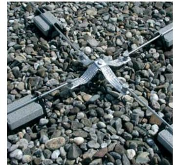
Fig. 5.4.1.1: Instalación captadora. Compensación de dilatación mediante bridas de puenteo.
