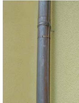
Fig. 5.2.2.2.4: Derivador instalado a lo largo de la tubería.
