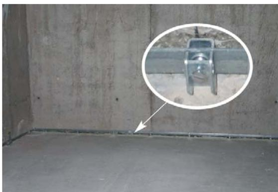
Fig. 7.4.2: Anillo de compensación de potencial en una instalación de ordenadores.
