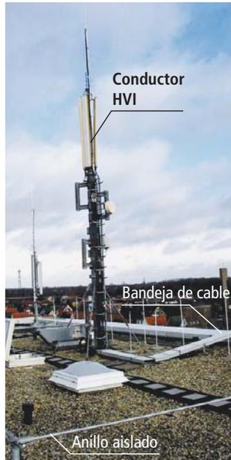
Fig. 5.2.4.3.2: Instalación captadora aislada y anillo aislado.
