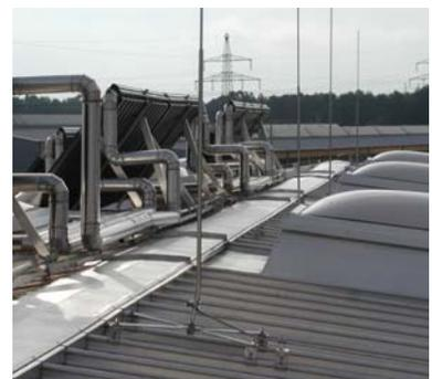
Fig. 5.1.4.7: Punta captadora para un lucernario en un tejado con junta redonda.
