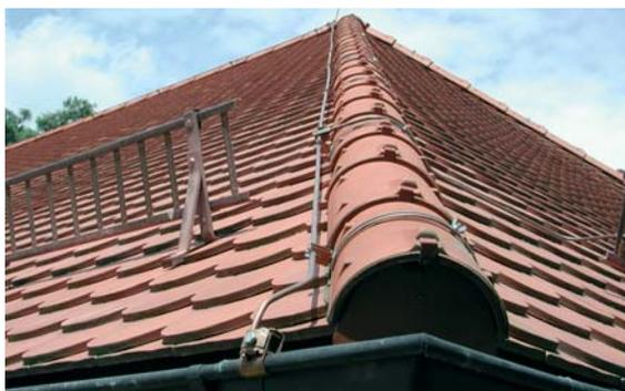
Fig. 5.1.1.18: Tejado a dos aguas con soportes para conductor.
