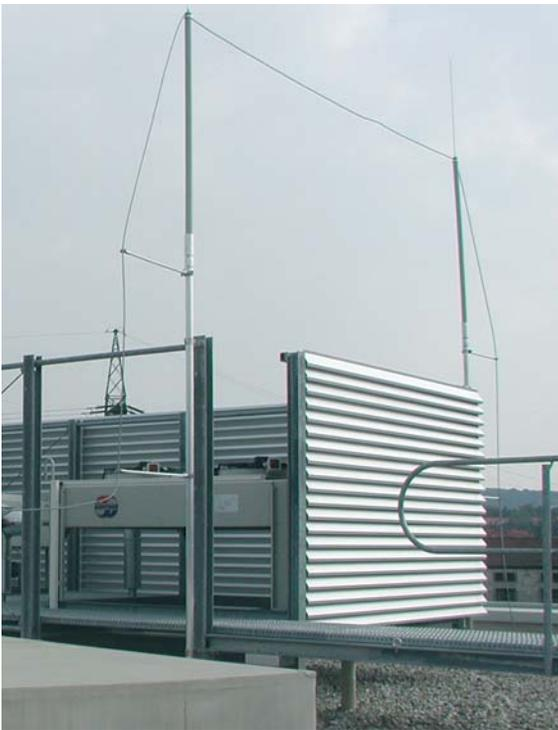
Fig. 5.1.8.14: Instalación captadora aislada con DEHNiso-Combi.
