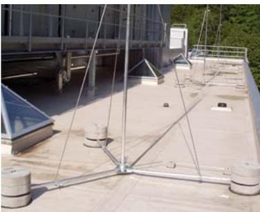
Fig. 5.1.8.7: Instalación captadora aislada para estructuras sobre el tejado.
