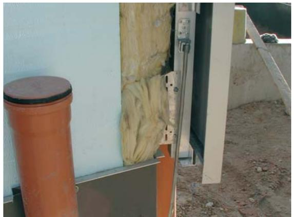
Fig. 5.2.2.2.3: Conexión a tierra de una fachada metálica.
