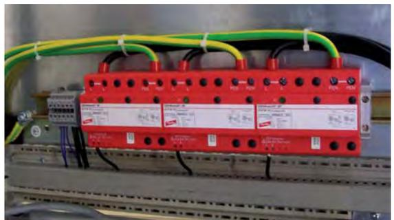
Fig. 9.16.4 Aplicación del descargador de corriente de rayo coordinado modelo DEHNbloc Maxi para sistemas 400/690 V TN-C.
