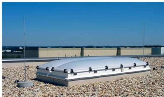
Fig. 5.1.1.17: Protección contra descargas directas de rayo de estructuras pequeñas sobre cubierta mediante puntas captadoras.
