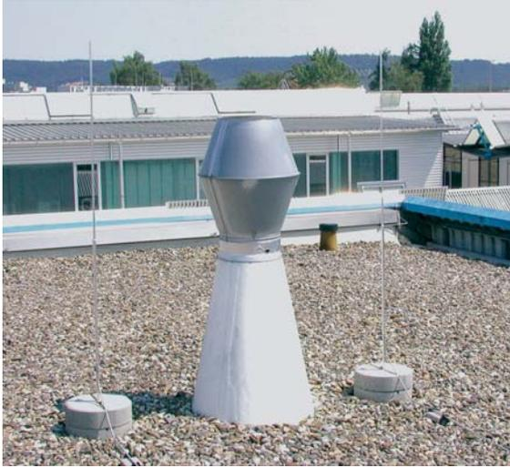
Fig. 5.1.8.2: Instalación captadora aislada. Protección con punta captadora.
