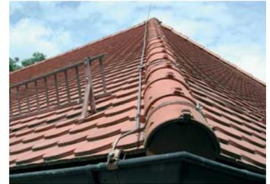
Fig. 5.2.2.1.3: Instalación captadora con conexión al canalón del tejado.
