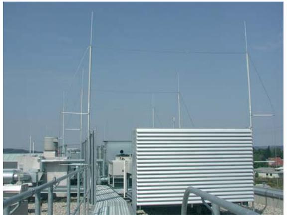
Fig. 5.1.8.12: Instalación captadora aislada con DEHNiso-Combi.
