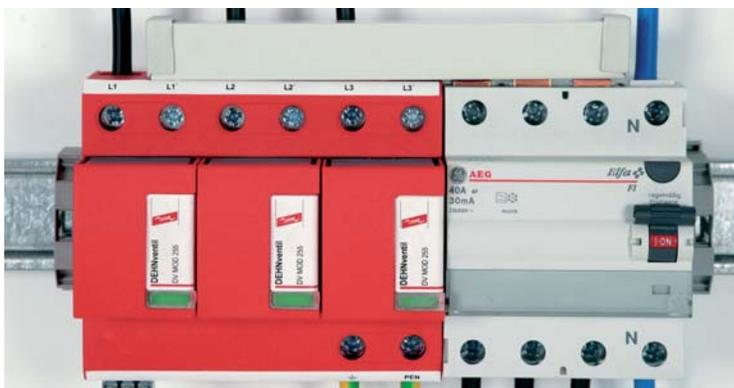
Fig. 8.1.6.11: Cableado serie en -V- del descargador combinado de corriente de rayo y sobretensiones DEHNventil M TNC mediante regleta de peine.
