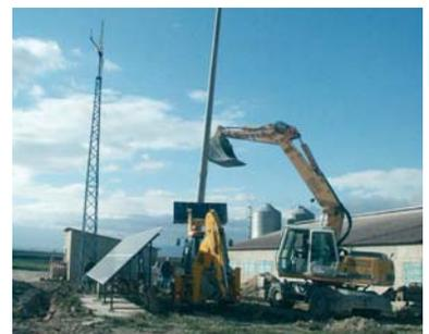
Fig. 5.1.8.9: Instalación de un mástil telescópico de protección contra el rayo.
