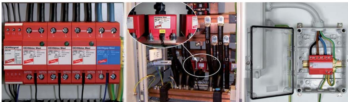
Fig. 7.5.2.7: Descargadores de corriente de rayo en la zona de intersección LPZ 0A-1.
