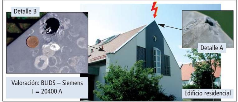
Fig. 5.1.4.2: Ejemplo de daños: cubierta de chapa.
