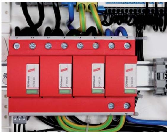
Fig. 7.8.1.3: DEHNventil M TNS – Descargador combinado modular.
