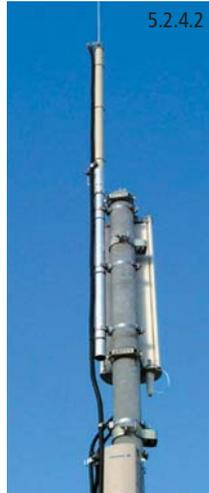
Fig. 5.2.4.2: Instalación captadora aislada para antenas de telefonía. Aplicación del sistema DEHNconductor.
