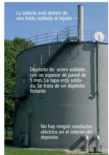
Fig. 9.3.8: Depósitos de acero soldados. (Fuente: Eisenbau Heilbronn GmbH).
