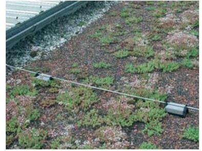
Fig. 5.1.7.3: Guiado de los conductores por encima del recubrimiento.
