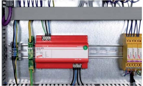
Fig. 7.7.3.1: Protección de equipos de electrónica industrial (p. ej. un SPC) con el BLITZDUCTOR XT y el SPS-Protector.
