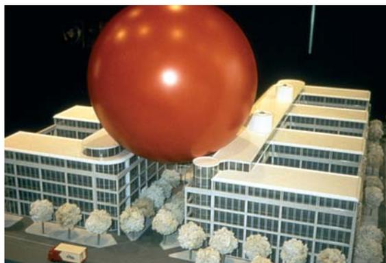
Fig. 5.1.1.4: Edificio administrativo de nueva construcción: Modelo con "esfera rodante" nivel de protección I.
