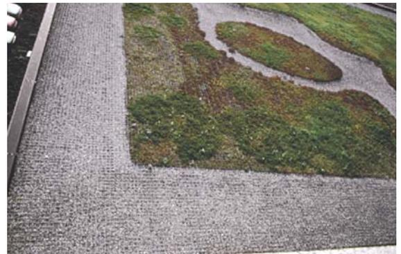
Fig. 7.3.7b: Utilización de rejillas de acero para blindaje, p. ej. en cubiertas de tejado ajardinadas.
